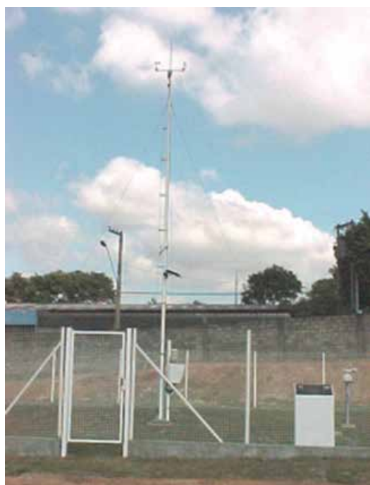
Figura 05 – Estação Meteorológica Automática
