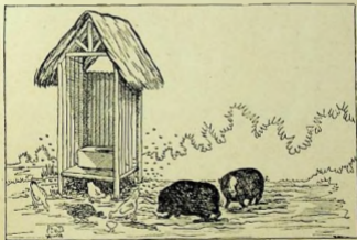
Fig. 13 — Primitivo e condenado tipo de instalação sanitária.
