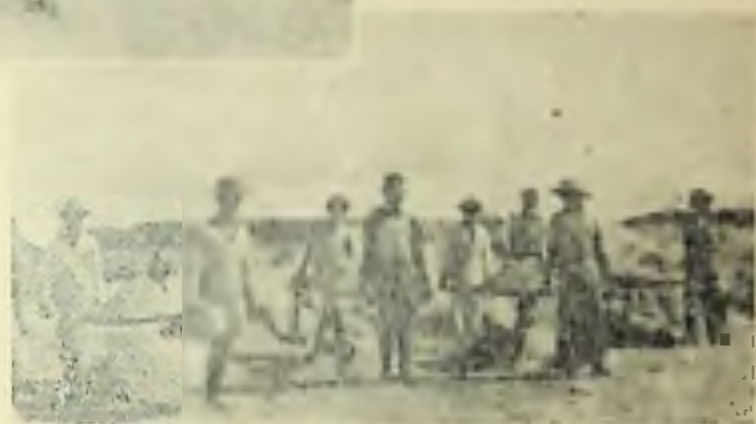
Trabalhos de escavação para abertura da barra e condução da areia por meio dos "linguês".
